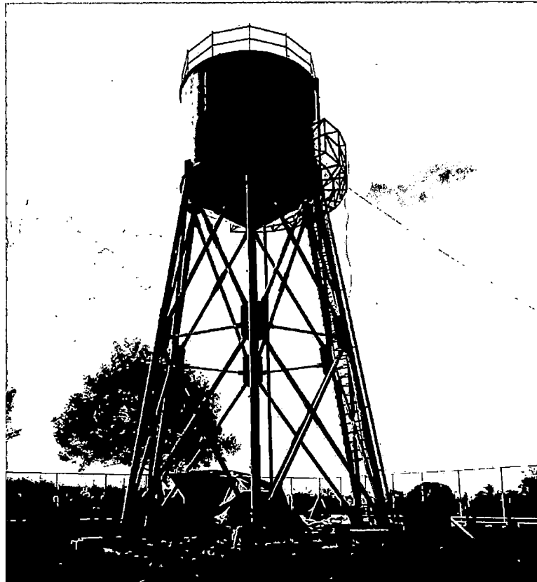
Figura 104. Tanque de agua potable.
