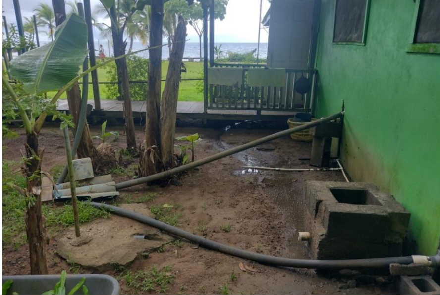
Figura 13 Componentes del sistema de trampa de grasas y aceites.
